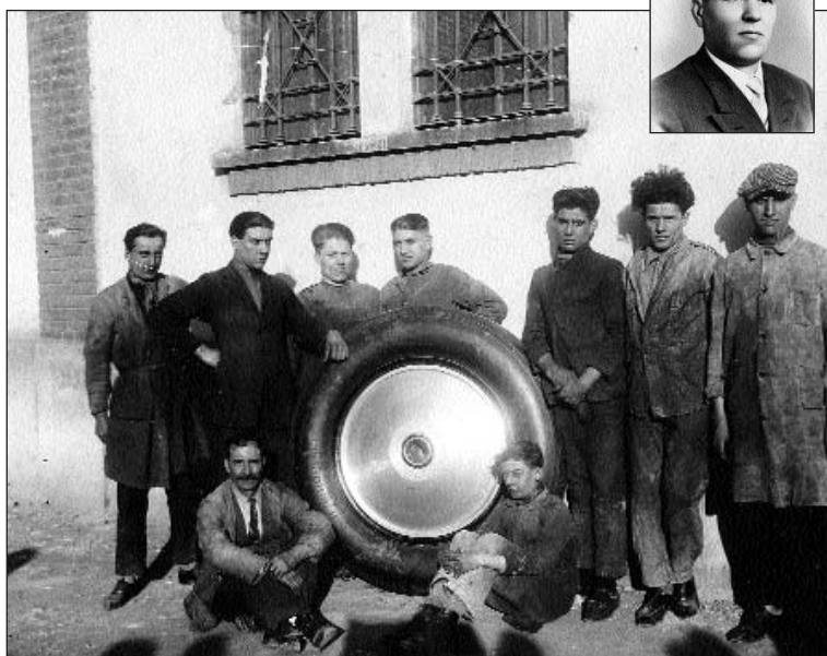
Lo stabilimento di via Palmanova. Cesare (in primo piano nel riquadro in alto) è il terzo da destra (anni '20).
